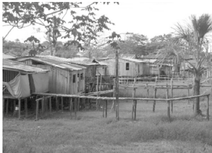
Figura 5.5 Arquitectura de viviendas construidas en palafitos y plataformas elevadas sobre la zona inundable del río Amazonas en la ciudad de Leticia
