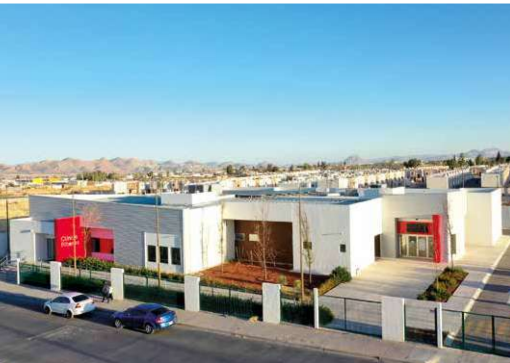
Construcción y equipamiento de la Clínica Riberas en la ciudad de Chihuahua para atención médica de calidad a más de 4 mil familias de la comunidad.
